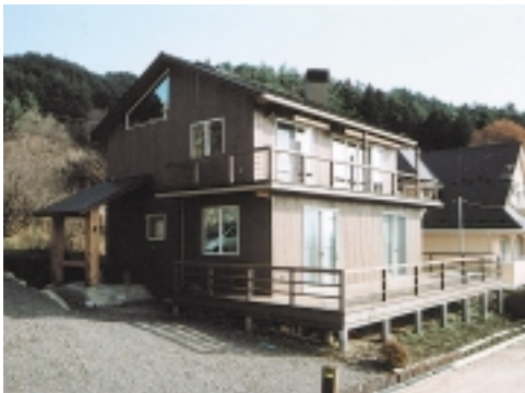
外観。内部の明るさを確保するため、開口部を増やしている
