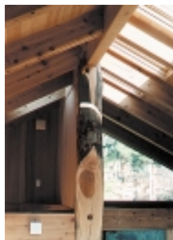
2階天井。明るく広がりある空間とするため、サイドライトやトップライトを配置。木を表出させた空間の重圧感を低減させている。中央の柱は施主自ら選定したケヤキの300角の通柱
