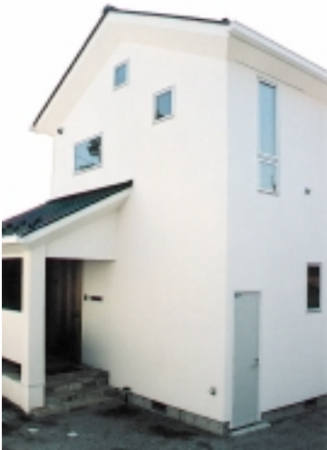
外壁は周辺の蔵づくりの街並みに溶け込むよう、モルタル塗りの上にスタッコ塗り
